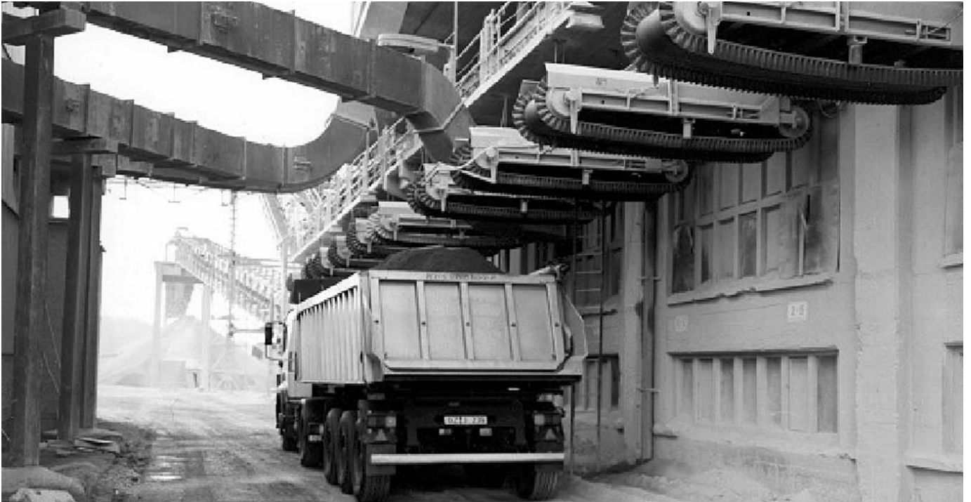
Distribuzione di sabbia abrasiva, sassi e ghiaia. Caratteristiche del mototamburo: affidabile, compatto, NESSUNA manutenzione, tenuta IP66/67.
